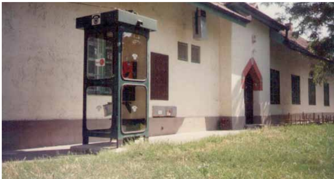
5. A Tábor Központ bejárati frontja felújítás után (2003)
