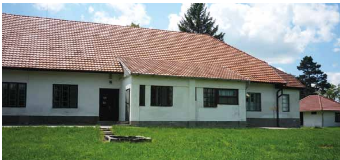
7. A Tábor Központ hátsó frontja felújítás után (2012)
